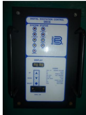
Figura 4.3 Vista frontal del regulador automático de voltaje Basler DECS 125-15.
